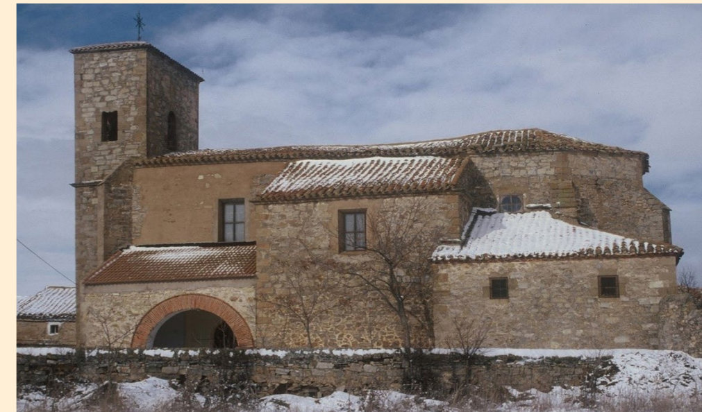
Iglesia parroquial de Valdelagua del Cerro.
