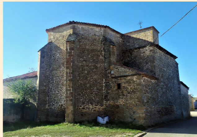
Iglesia parroquial. Ábside y muro norte. Se aprecia la sobreelevación de la nave sobre los contrafuertes y los volúmenes de la capilla del presbiterio, el crucero y la dependencia de subida al coro.
